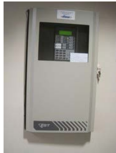
Main EST fire alarm panel
