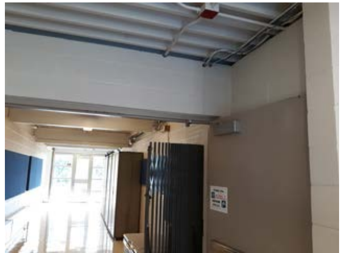
Corridor door hold-opens
